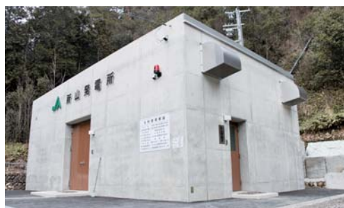
更新工事を終えた廿日市市の所山小水力発電所 (JA佐伯中央)
